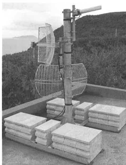
図2 諏訪之瀬島へき地集会室屋上に設置したパラボラアンテナ。
