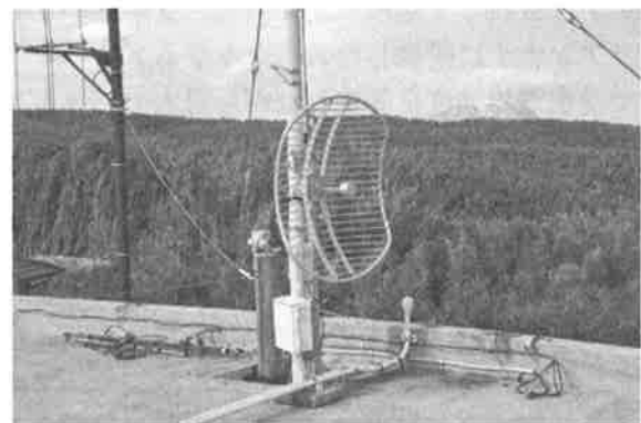
図2 竹島出張所屋上。鳥が止まりアンテナがずれることを防ぐため、結束バンドをアンテナ上部に取り付けた。
